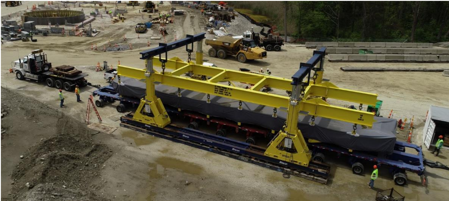
Unloading a HRSG module
